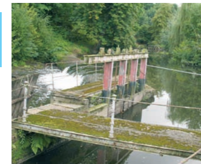
Ouvrage sur le Noireau
